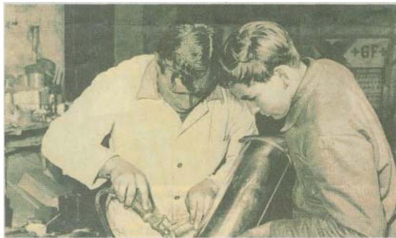
Siegfried Strehl (rechts) half als 17 Jahre alter Geselle seinem damaligen Meister Hermann Schweizer beim Verlöten der Dokumentenkapsel für den sanierten Überlinger Münsterturm.
